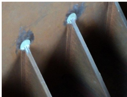
Figura 12. Utilización de mástic para el sellado de ojales en elementos inaccesibles metálicos, creando recintos estancos y protegidos, por tanto, contra la corrosión atmosférica.
