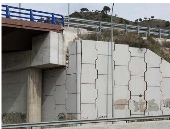
Figuras 29 y 30. Movimientos en muros de suelo reforzado por circulación de agua por su interior, produciendo el lavado de finos y los consiguientes asientos y acompañamientos de las placas.
