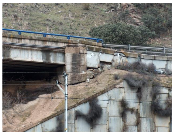
Figuras 31 y 32. Problemas en muros de suelo reforzado por asiento del terraplén, produciendo la rotura parcial de placas, así como hundimientos locales de la plataforma.
