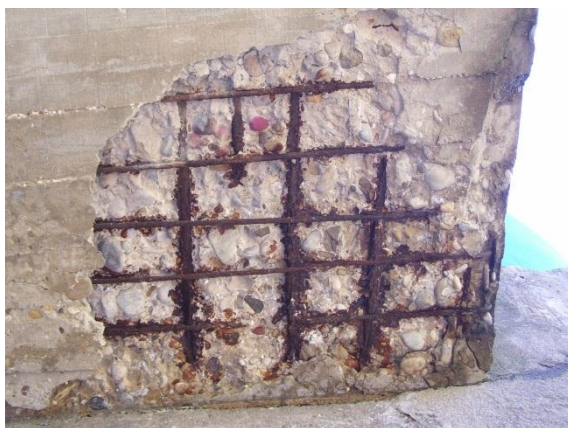
Figuras 7 y 8. Detalles de corrosión generalizada por carbonatación del hormigón.
