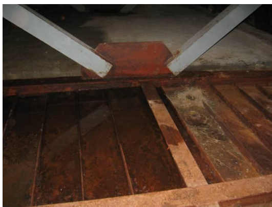
Figuras 25 y 26. Daños en cajón metálico debido a la entrada y acumulación de agua, produciendo la corrosión generalizada del interior de la estructura.
