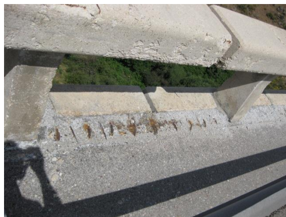
Figuras 33 y 34. Deterioro de barandillas y pretilas de hormigón armado.
