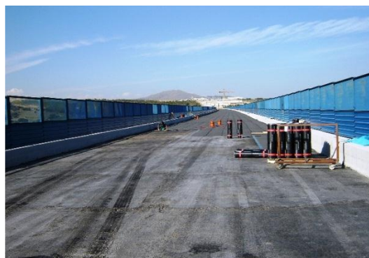
Figuras 38 y 39. Ejemplos de impermeabilización de tableros de puentes.
