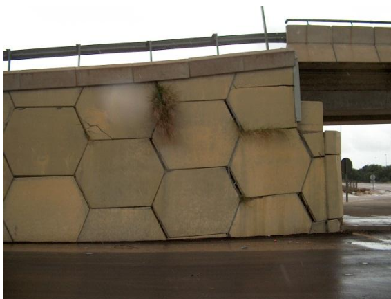
Figuras 31 y 32. Problemas en muros de suelo reforzado por asiento del terraplén, produciendo la rotura parcial de placas, así como hundimientos locales de la plataforma.
