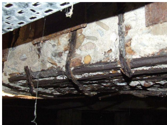
Figuras 7 y 8. Detalles de corrosión generalizada por carbonatación del hormigón.
