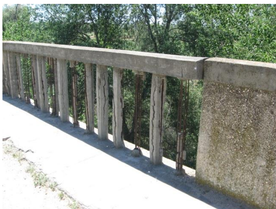
Figuras 33 y 34. Deterioro de barandillas y pretilas de hormigón armado.
