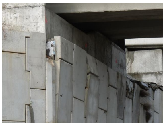
Figuras 29 y 30. Movimientos en muros de suelo reforzado por circulación de agua por su interior, produciendo el lavado de finos y los consiguientes asientos y acompañamientos de las placas.
