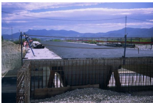
Figuras 38 y 39. Ejemplos de impermeabilización de tableros de puentes.
