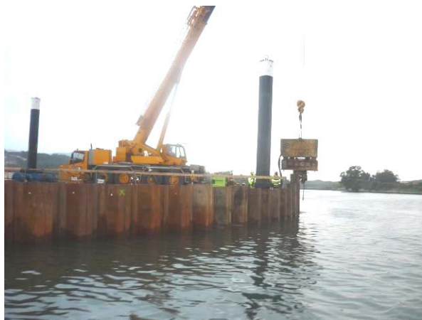
Figura 8 a y b. Hincado de tablestacas y colocación de zunchos
