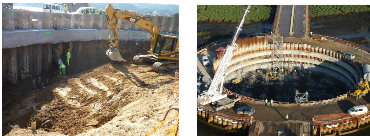
Figura 10 a y b. Fase intermedia de excavación y recinto de pila 5 en máxima excavación
