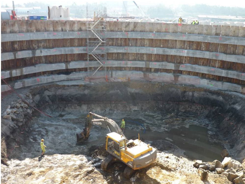
Figura 14. Recinto de pila 7 en fase de máxima excavación
