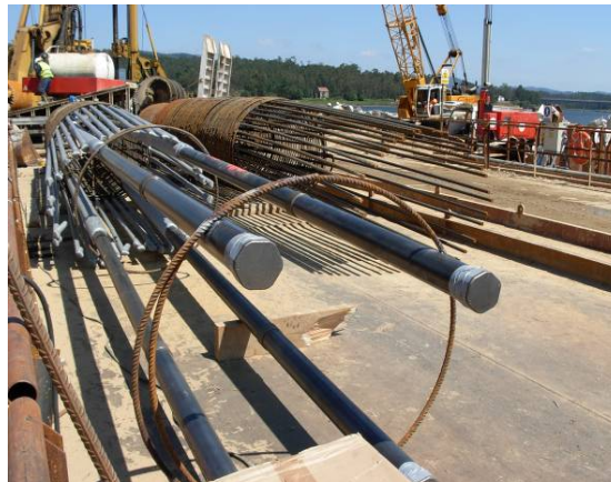
Figura 12 a y b. Tres pilotadoras trabajando en pila 6 y armadura con tubos sónicos.
