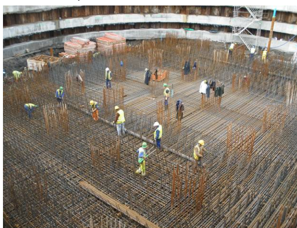
Figura 13 a y b. Descabezado de pilotes y montaje de la ferralla del encepado.
