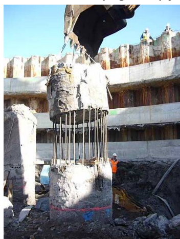
Figura 13 a y b. Descabezado de pilotes y montaje de la ferralla del encepado.
