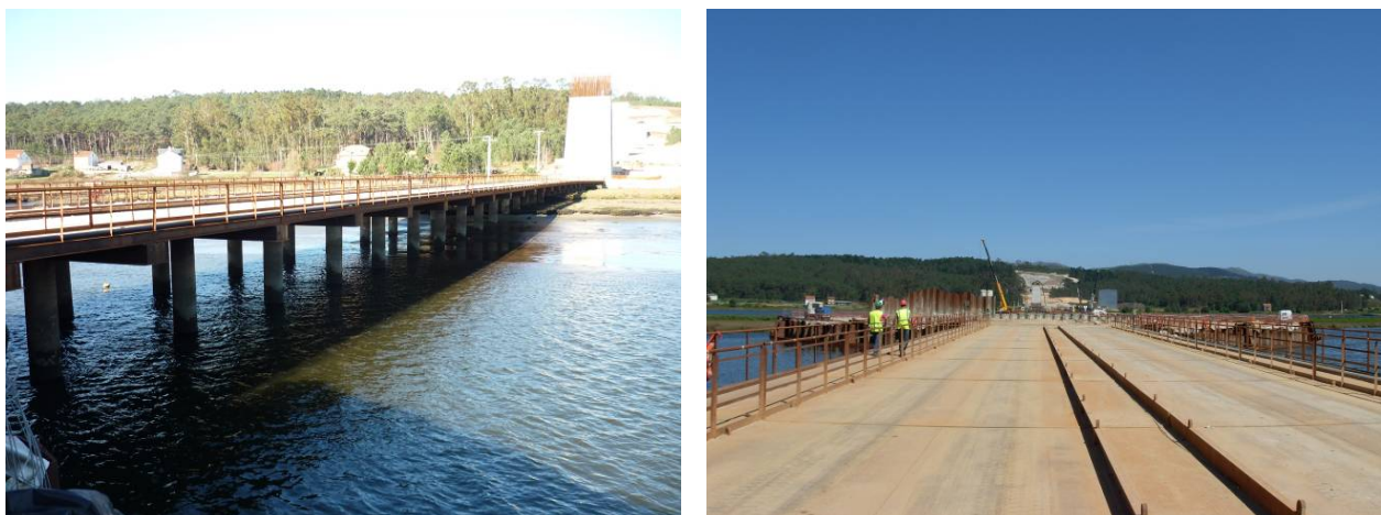
Figura 6 a y b. Imágenes del pantalán finalizado
