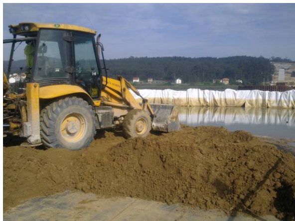
Figura 9 a y b. Relleno del recinto e hincado de tablestacas interiores
