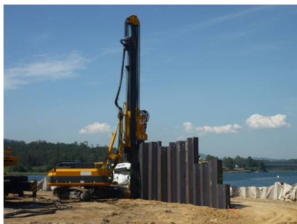
Figura 9 a y b. Relleno del recinto e hincado de tablestacas interiores
