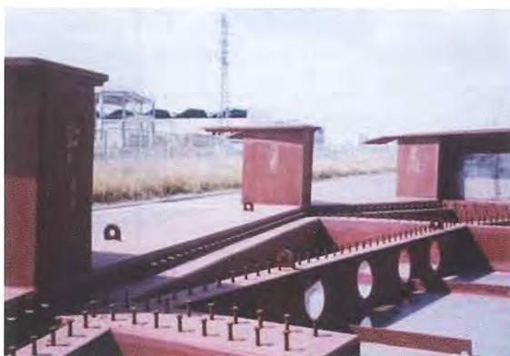
Photo 5 : Montage de cadre de stabilité / Erection of stability frame
