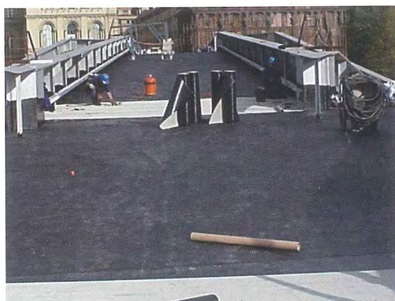
Photo 22 : Mise en place de l'étanchéité / Waterproofing laying
