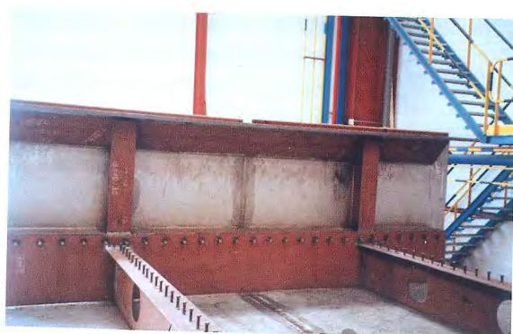
Photo 2 : Ossature intérieure en acier autopatinable / Internal stiffening elements in weathering steel
