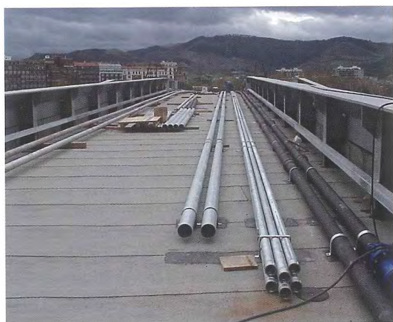
Photo 21 : Pose des fourreaux / Laying of sheaths
