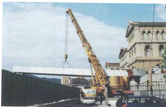
Photo 14 : Montage du tronçon latéral du tablier principal / Erection of main deck lateral segment
