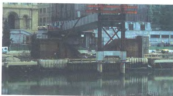
Photo 15 : Palée provisoire / Temporary pier
