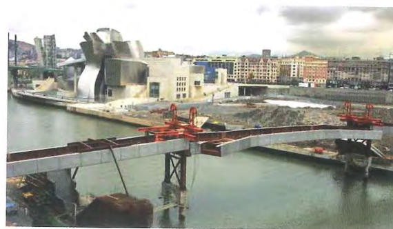
Photo 18 : Montage du tronçon central - Hissage / Erection of central segment - Lifting
