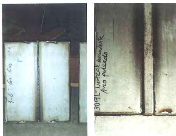
Photos 13a et 13b : Soudure sur lattes extérieures / Welding on external backing plates
