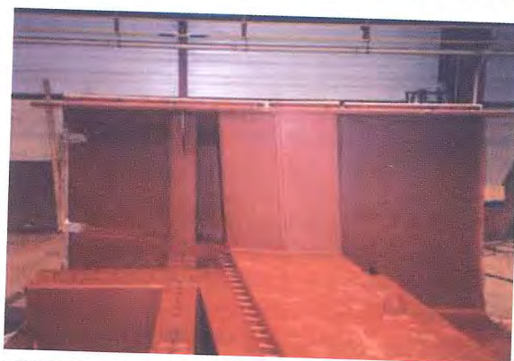
Photo 6 : Cadres raidisseurs courants / Current stiffening frames
