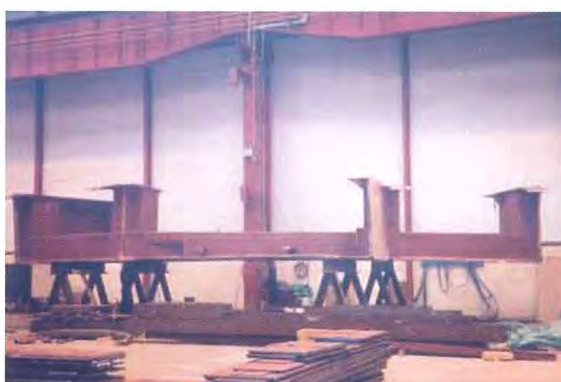
Photo 4 : Cadre de stabilité en fabrication / Fabrication of stability frame
