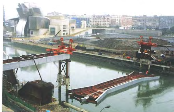
Photo 17 : Montage du tronçon central - Mise à l'eau / Erection of central segment - Floating into position
