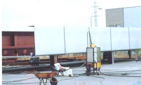
Photo 13c : Soudage au chantier / Site welding
