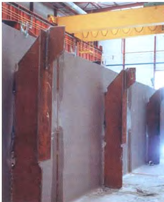
Photo 10 : Début de soudage des raidisseurs intérieurs / First stages of internal stiffener welding
