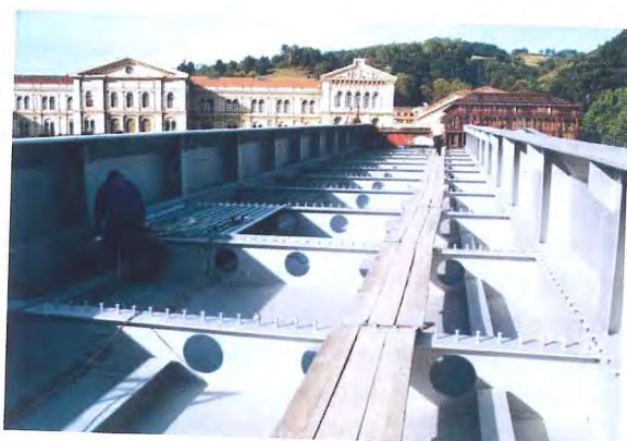
Photo 6 : Cadres raidisseurs courants / Current stiffening frames
