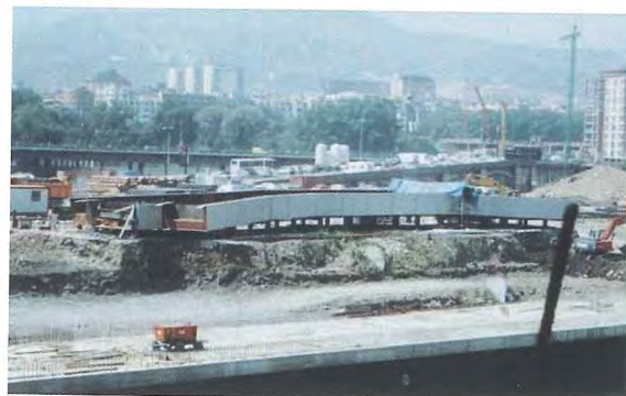
Photo 16 : Assemblage du tronçon central du tablier principal / Worksite pre-assembly of main deck central segment
