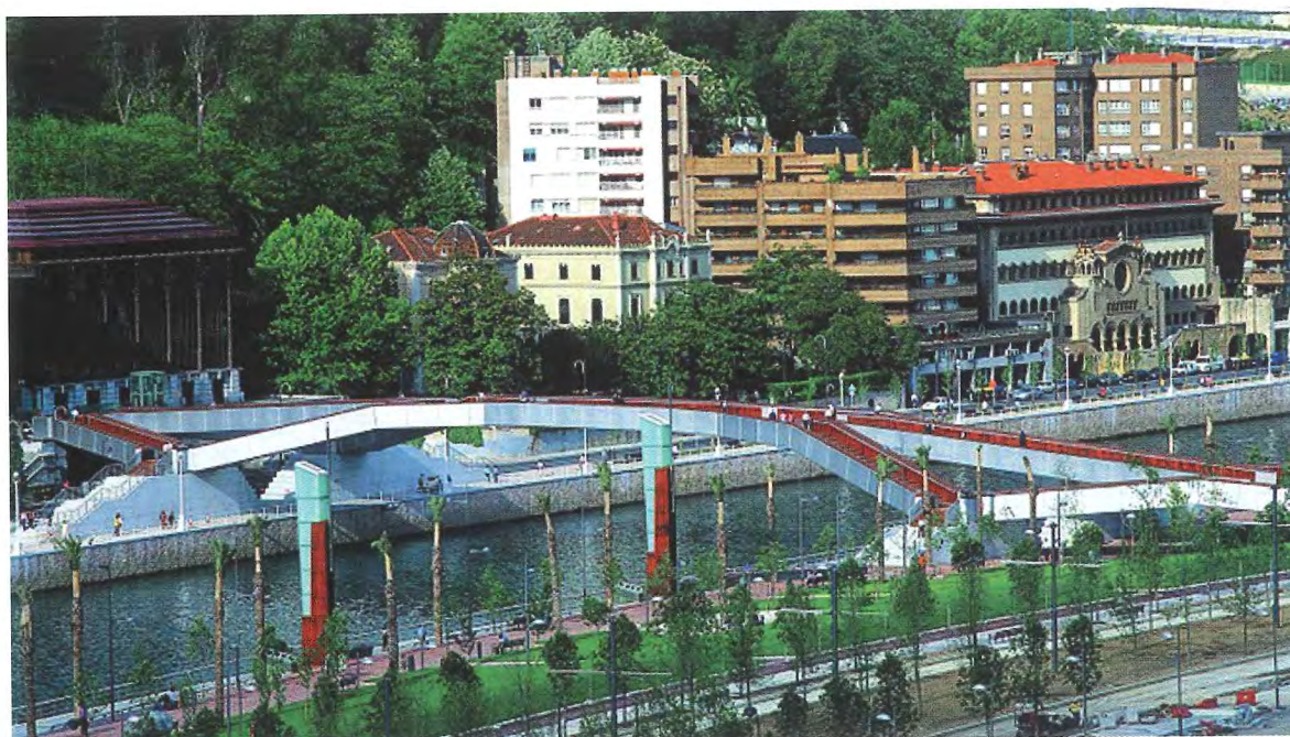
Photo 27 : Ouvrage ouvert au public / Bridge open to public
