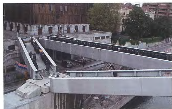
Photo 8 : Construction des rampes et de la dalle butée en béton / Construction of ramps and mobile concrete slab
