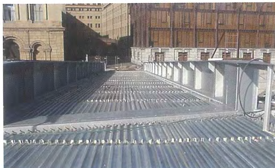
Photo 20 : Bac acier galvanisé pour coulage de la dalle / Galvanised sheeting for concrete deck
