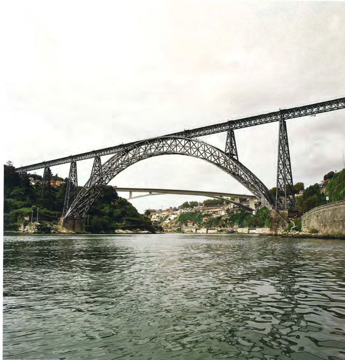
11. Puente de María Pía, en la actualidad (Fotografía: Millanes)
