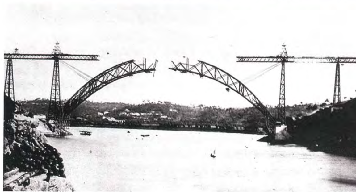
12. Puente de María Pía, en construcción (Fotografía: Millanes)
