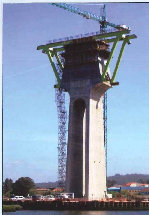
Рис. 3. Общий вид опор центральной секции моста P-5 и P-8
