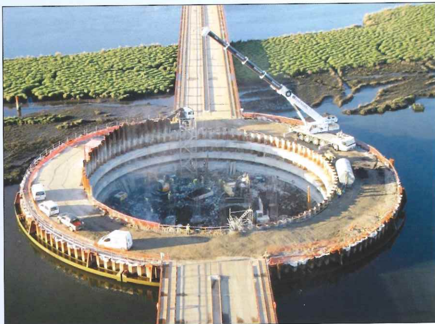
Рис. 6. Разработка котлована в акватории реки для бетонирования плиты свайного ростверка опоры Р-5
