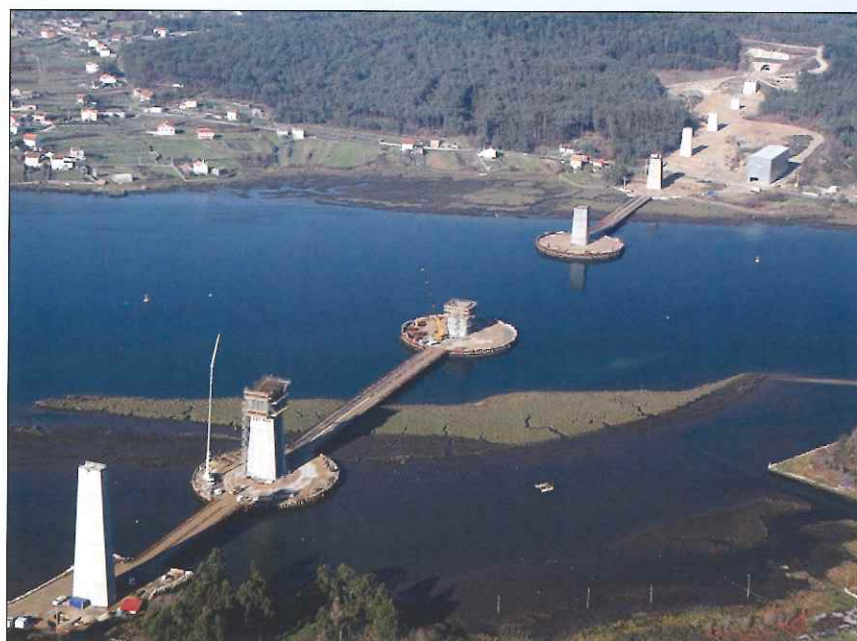
Рис. 7. Вид сверху на сооружение промежуточных опор в акватории реки
