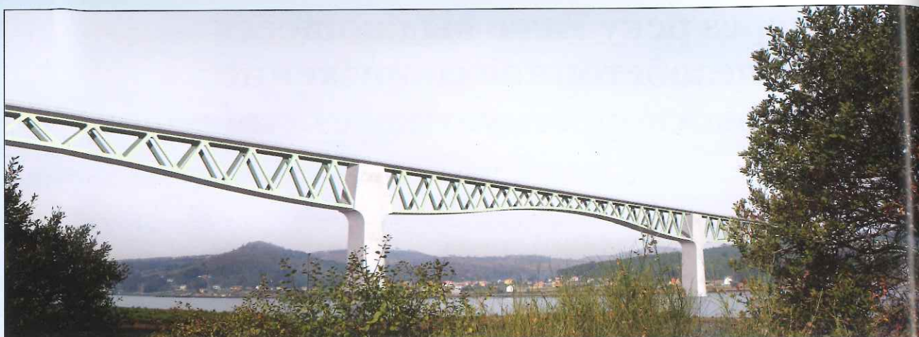
Рис. 2. Мост через реку Улла (вид сбоку)
