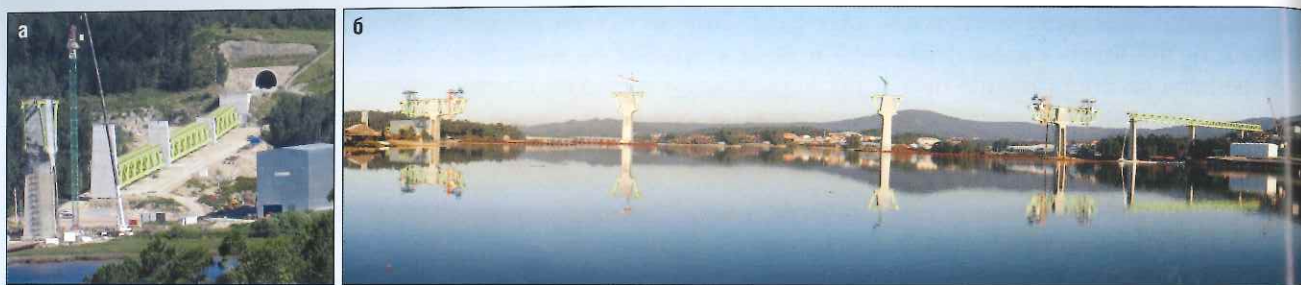
Рис. 12. Пролетные строения вблизи устья А2 (120 + 120 + 80 м), подготовленные к монтажу подъемом (а); состояние работ на момент написания статьи (б)
