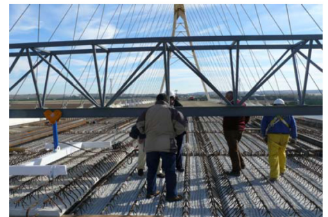
写真-6 プレキャストコンクリート板の敷設状況
