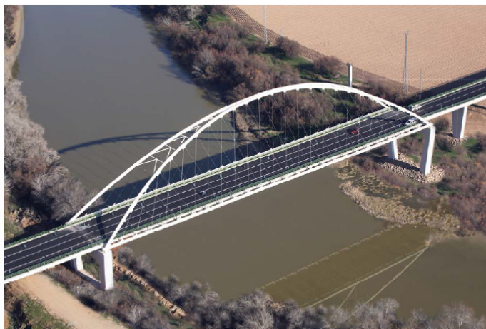
写真-1 橋梁全景
