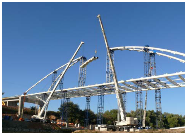
写真-5 アーチリブの架設状況
