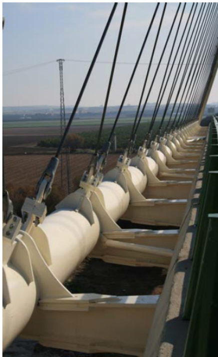
写真-2 吊り材と弦材の定着部
