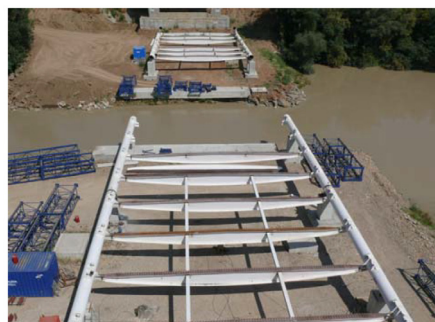
写真-4 築堤上での補剛桁の地組み状況
