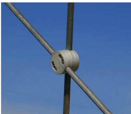
写真-3 吊り材の交点クランプ
