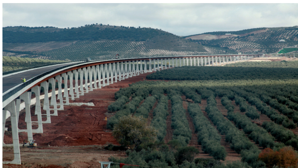
Figura 5. Vista del viaducto mixto de Archidona concluido
