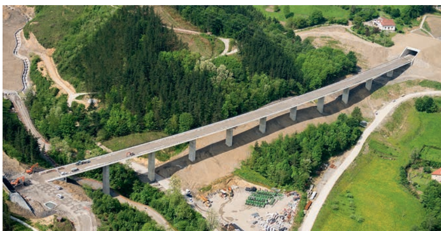
Figura 2. Imagen del viaducto de Lamiategui.
