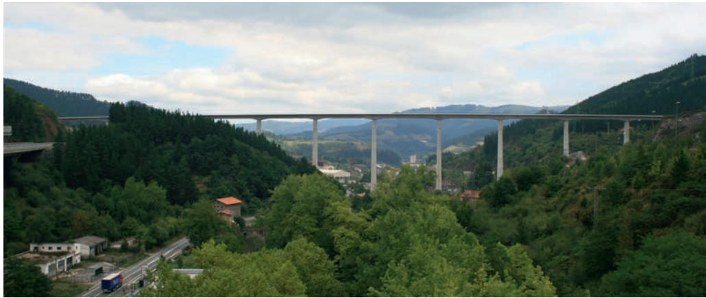
Figura 11. Imagen del viaducto construido de hormigón pretensado.
